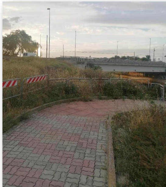
Figura 5 Stato attuale della sponda est già sede della pista ciclabile. La larghezza è di 3 metri e l'altezza di 2 metri.
