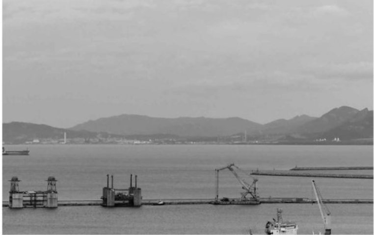
[F06] Infrastrutture marittime: veduta del molo di Ponente.
