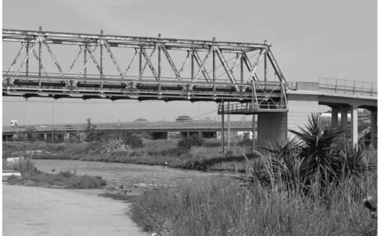
[F05] Infrastrutture marittime: il ponte di via dei Calafati.
