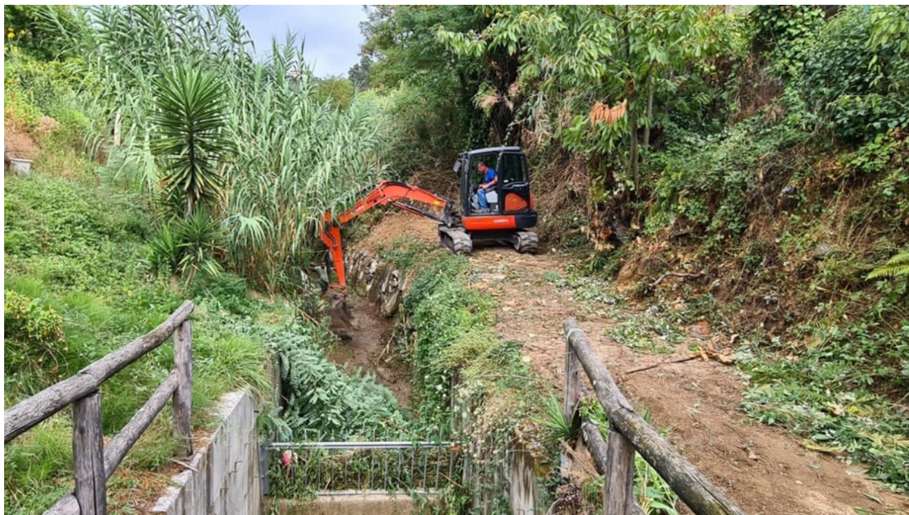
Fig. 37 - Esempi di manutenzione della rete di scolo
