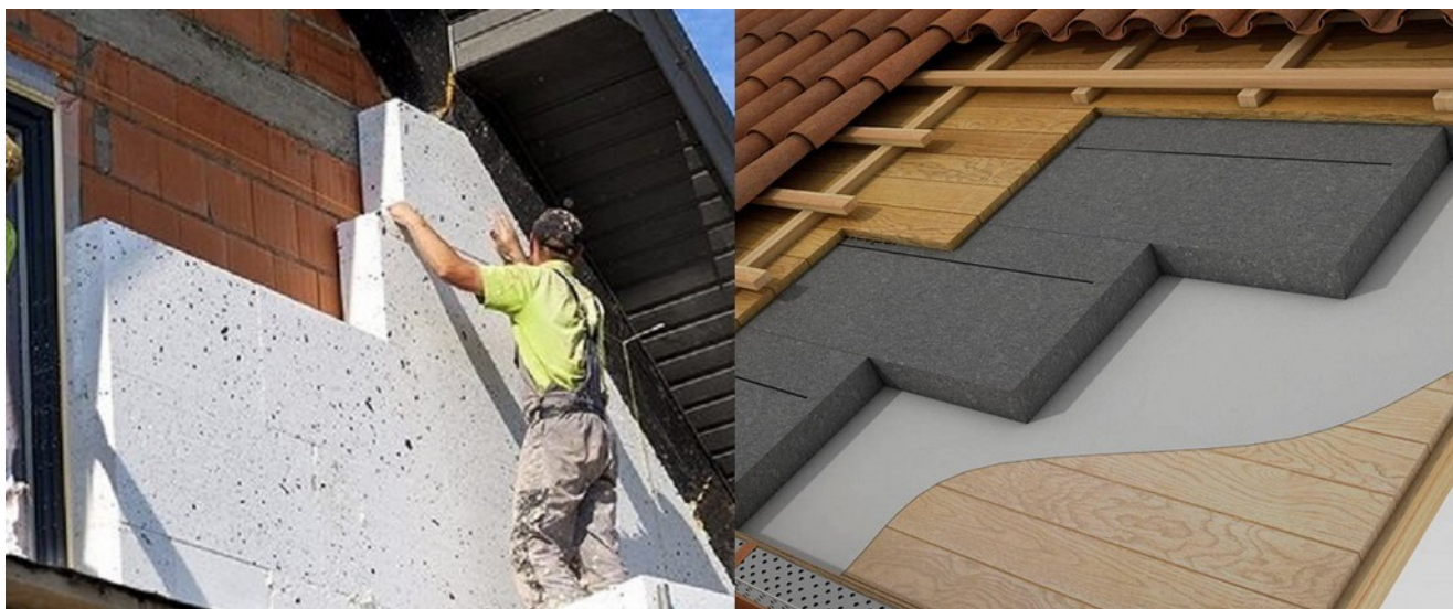
Fig. 21 - Isolamento termico di pareti e coperture
