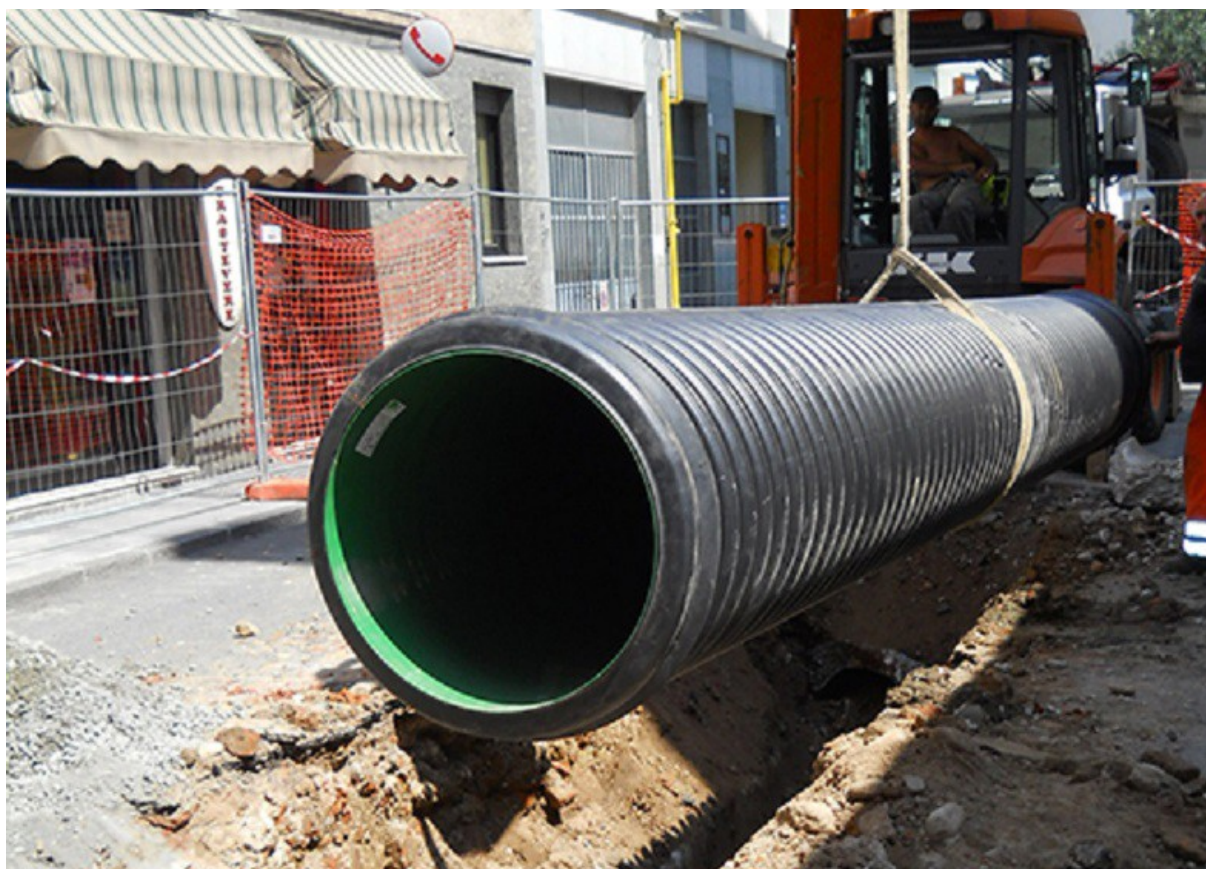
Fig. 40 - Adeguamento delle reti fognarie
