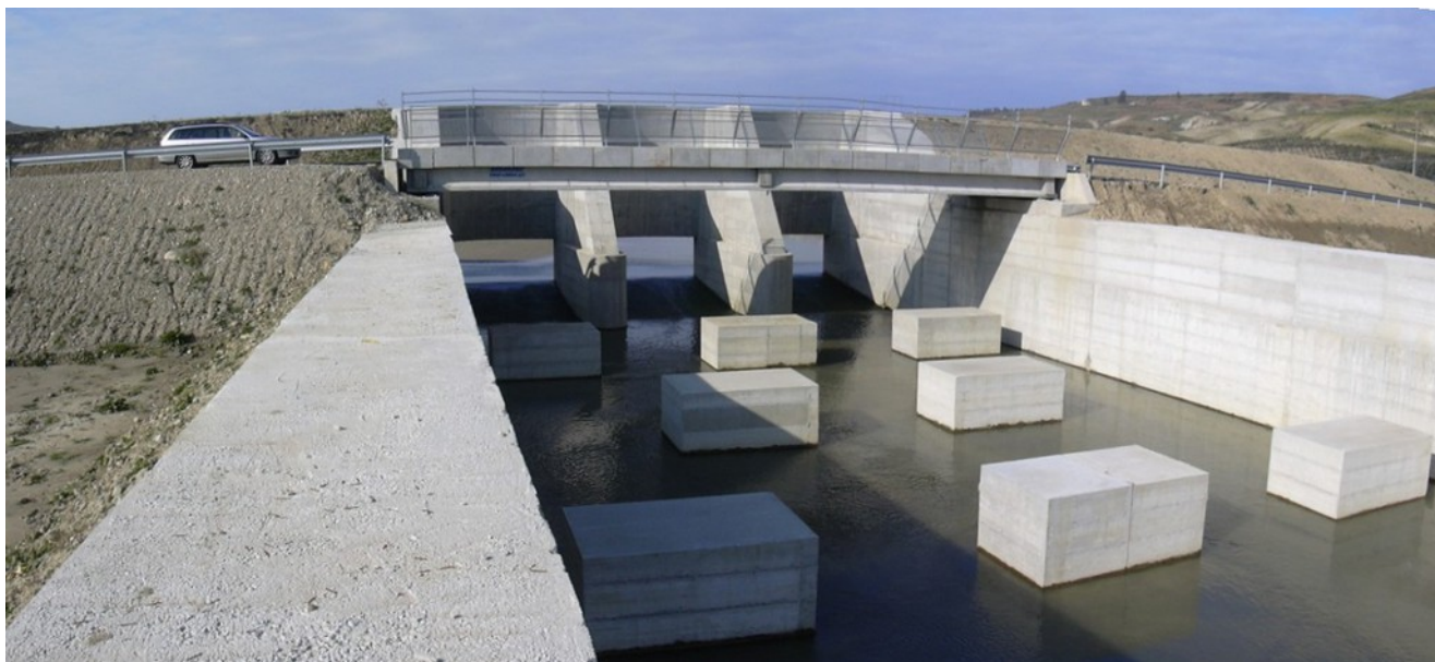
Fig. 33 - Cassa di laminazione in linea – particolare dello scarico di fondo
